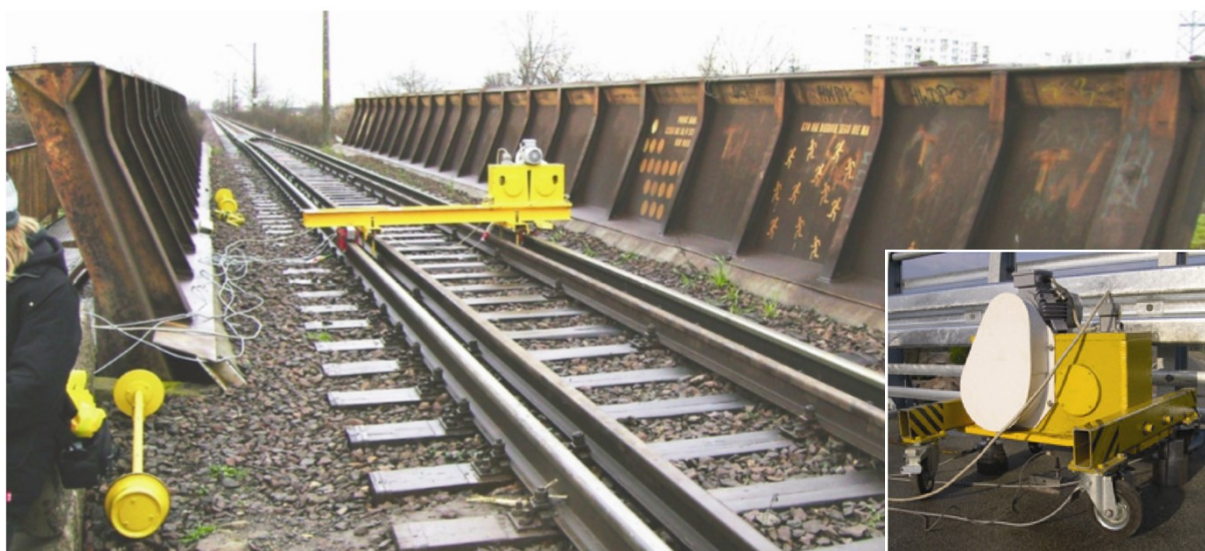
Figura 19 - Equipamento fixado sobre trilho e detalhe.
