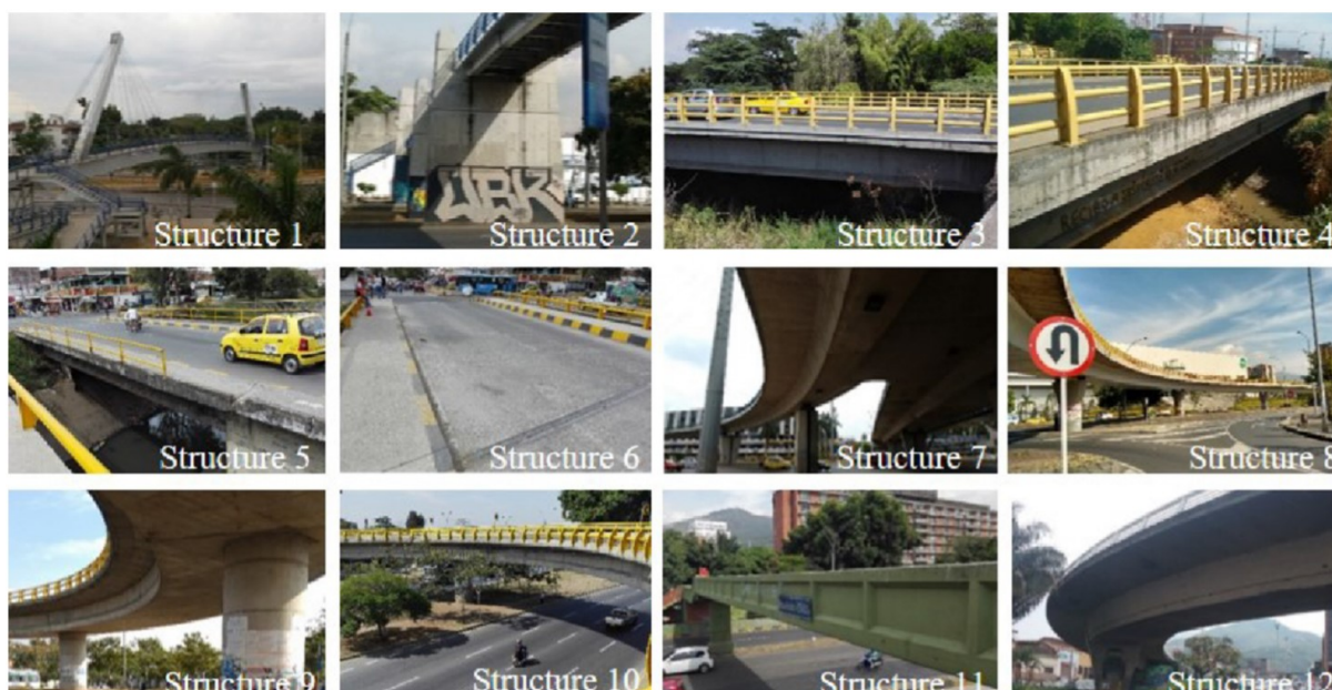
Figura 23 - Obras de arte especiais estudadas.
